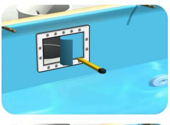
Tagliare con un **cutter** la parte del liner che si trova all'**interno** della **bocca dello skimmer** <u>seguendo il bordo interno</u>.
